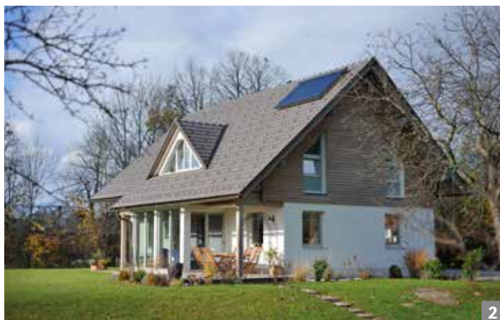
2 PRVA SKELETNA PASIVNA HIŠA V SLOVENIJI stoji v Zgošči pri Begunjah (zgrajena leta 2007). Lastnik je Franci Petek, svetovni prvak v smučarskih skokih. Izvajalec Eko produkt.
